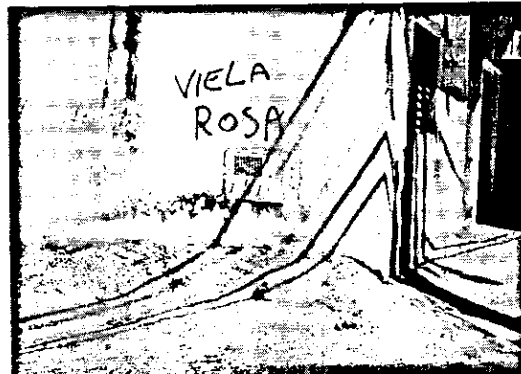
Vielas sem vazamentos e com caixa UMA com acesso à leitura
