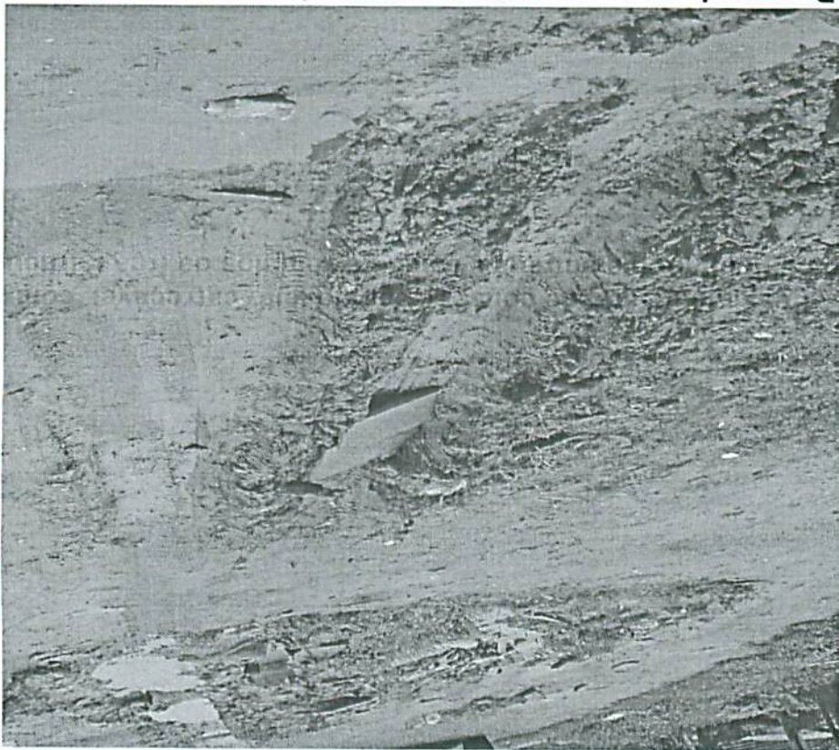
Foto 001 – Pêssimo estado de conservação do leito carroçável, com atoleiros imensos dificultando a entrada e saída de veículos da Rua Particular 1B
