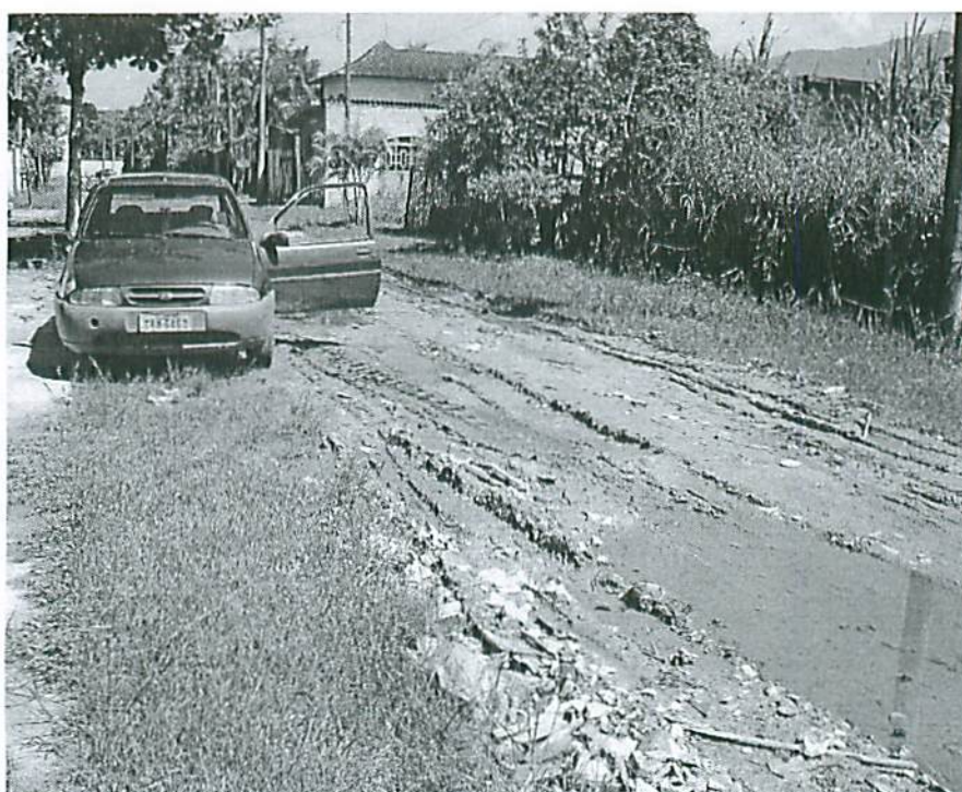
Foto 002 – Péssimo estado do leito carroçável com água parada e muito lixo
