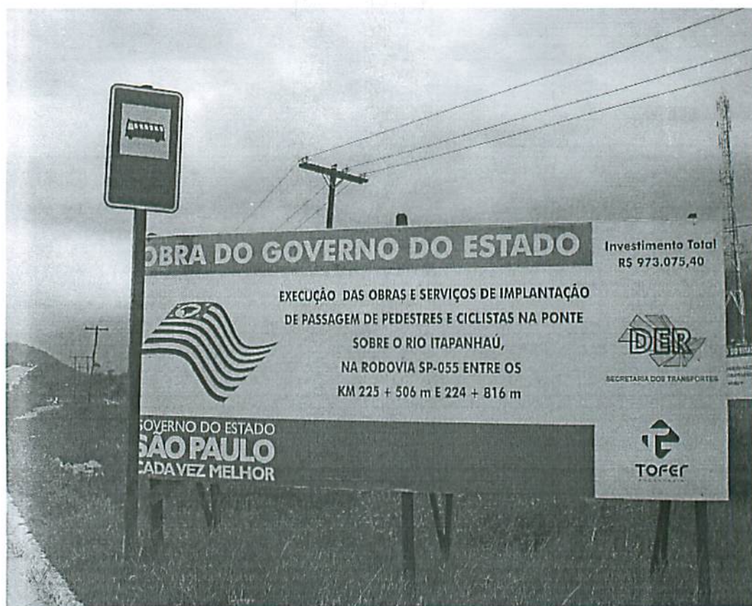
Placa da obra a ser realizada ao lado da ponte do Rio Itapanhaú
