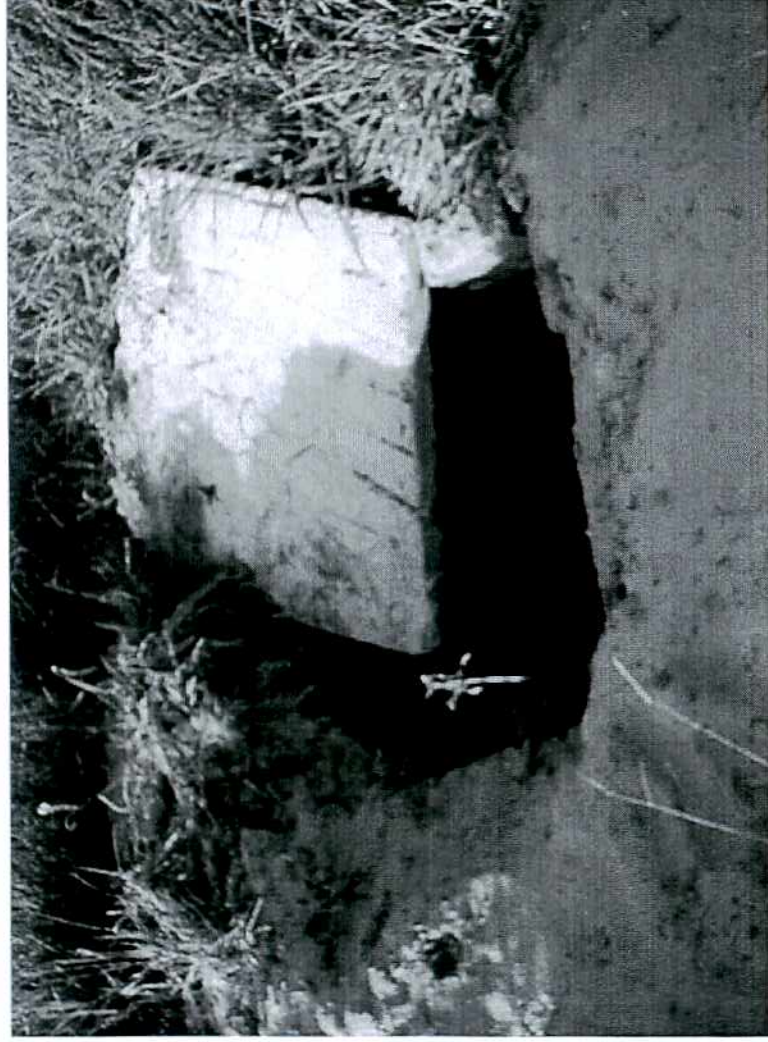
Foto 001: Caixa de inspeção sem tampa
