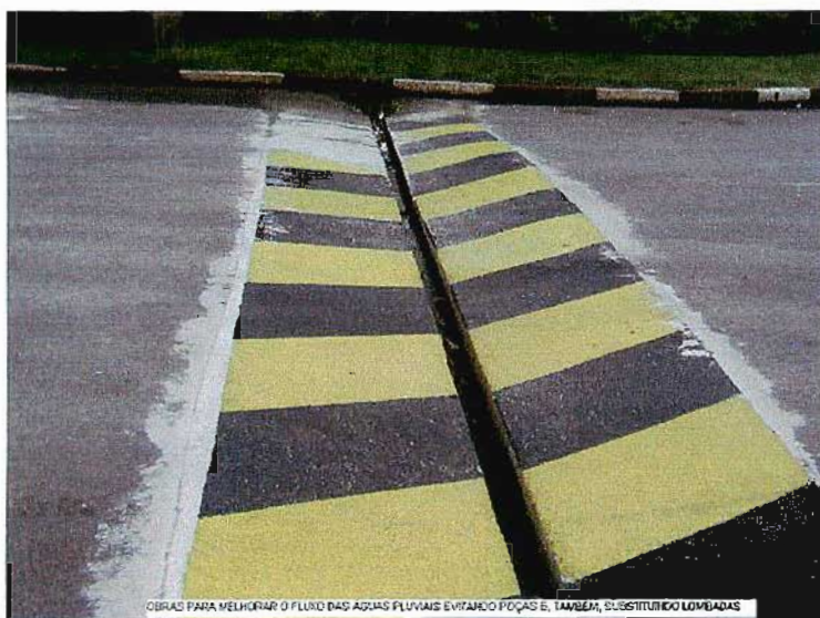
OBRAS PARA MELHORAR O FLUXO DAS ÁGUAS PLUVIAIS EVITANDO POÇAS E, TAMBÉM, SUBSTITUINDO LOMBADAS
