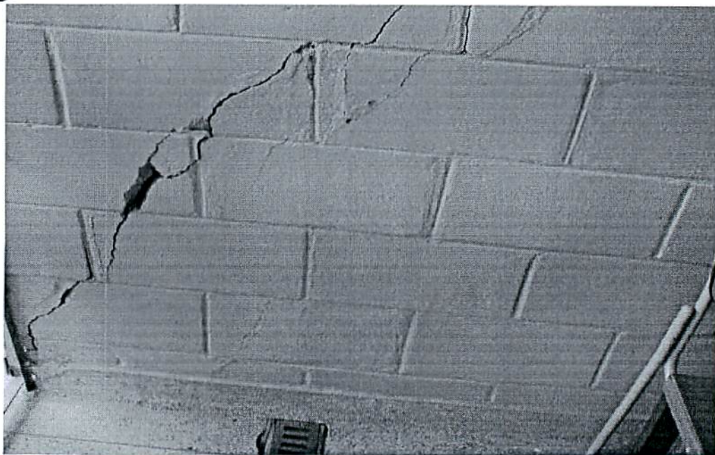
Rachadura em parede da Escola Estadual (Foto 001)
