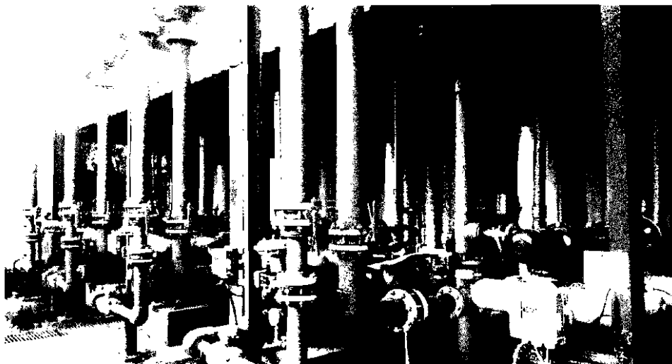
Figura 10 – Sistema Ultra Filtração ETA Itapanhaú
