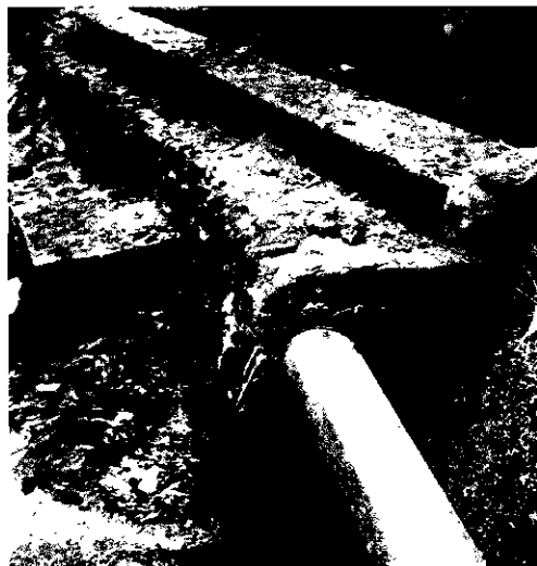
Figura 22 – Detalhe da tubulação da captação
