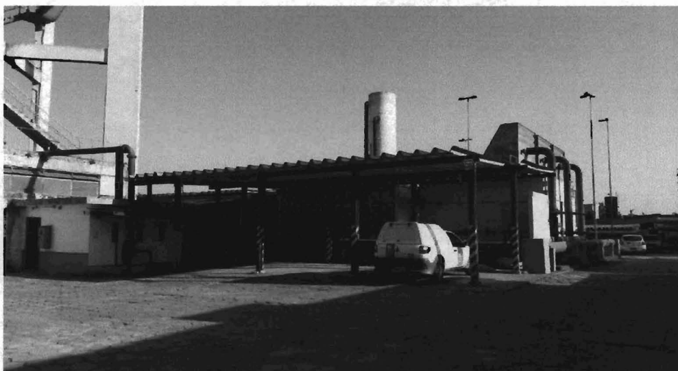
Figura 6 - Pátio da ETA FURNAS_PELAES
