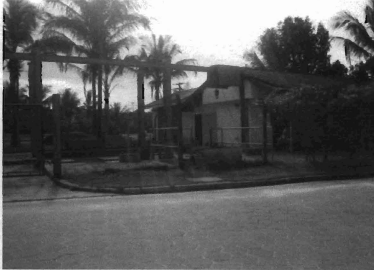
Figura 39 – Estação elevatória de Esgoto
