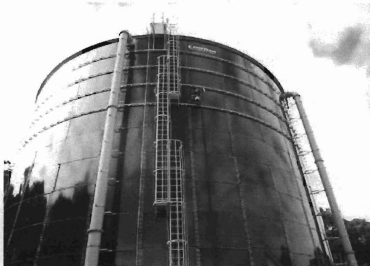
Figura 14 – Tanque reservação Riviera de São Lourenço
