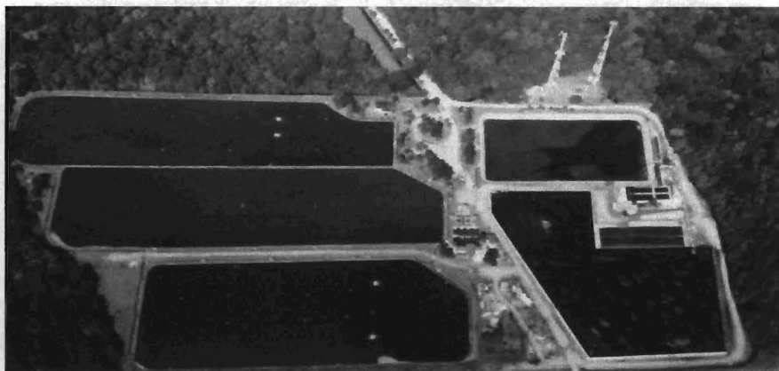
Figura 38 – Vista Aérea do ETE Riviera de São Lourenço
