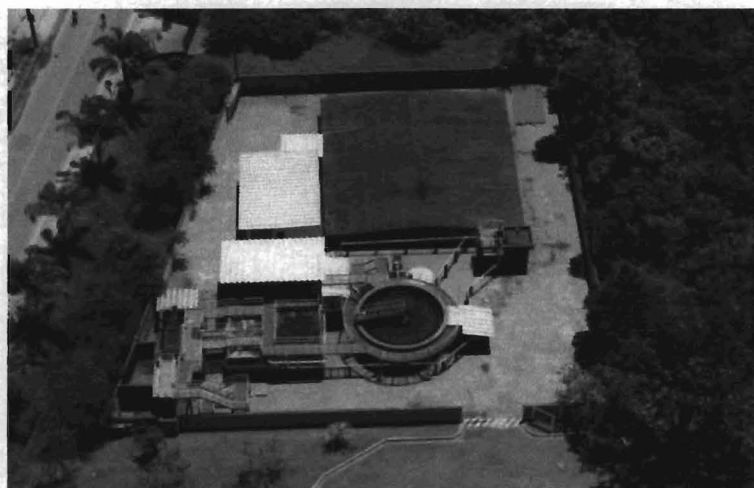
Figura 44 – Vista aérea da ETE SESC
