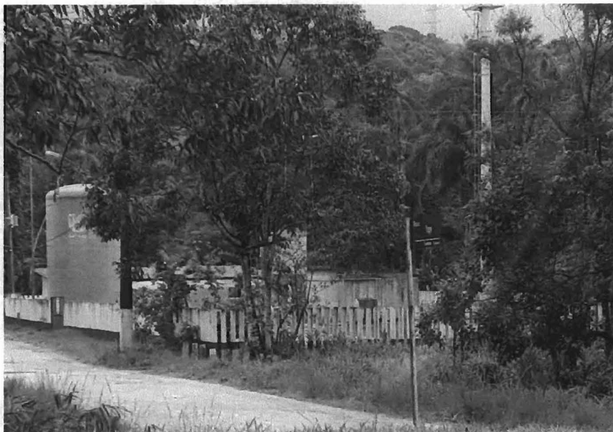
Figura 17 – Vista da ETA Caruara
