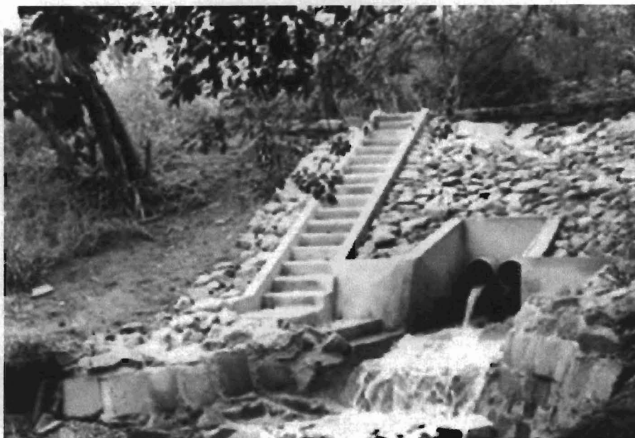
Figura 43 - Lançamento do efluente
