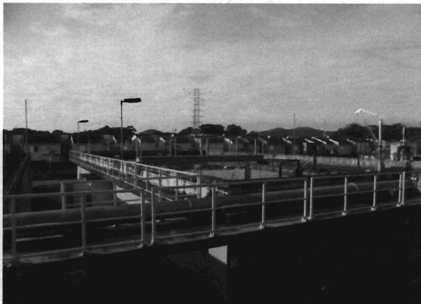
Figura 32 – Módulos de tratamento da ETE Bertioga
