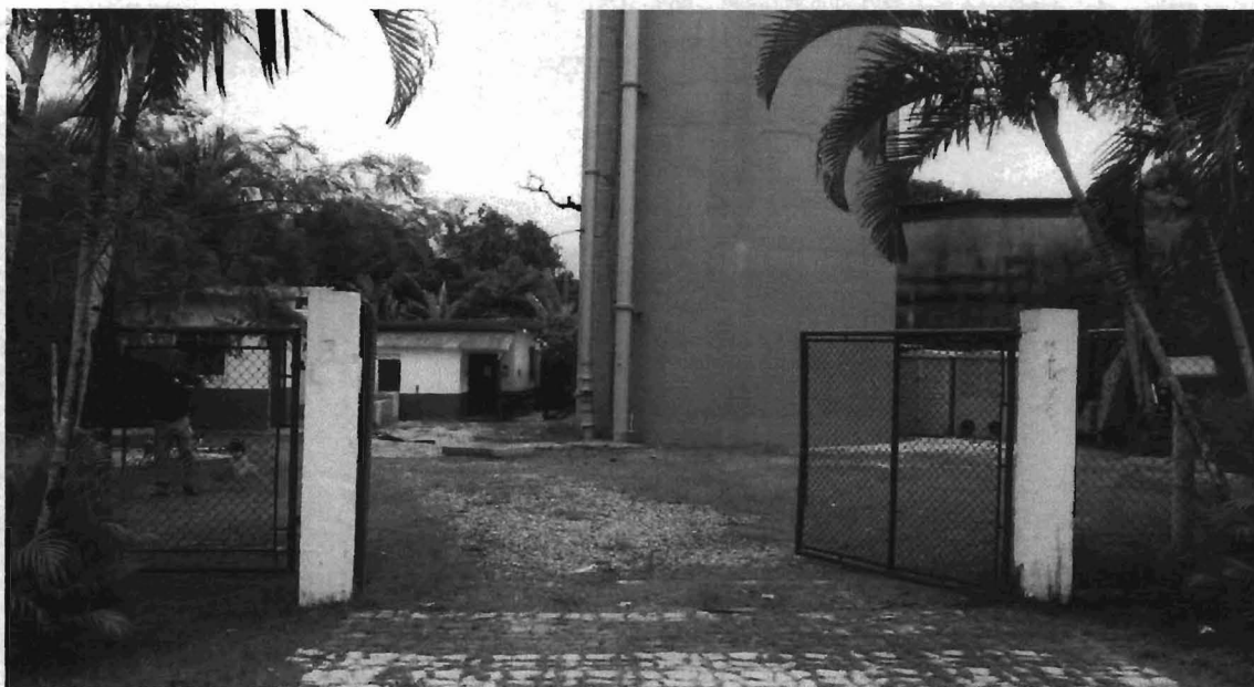
Figura 20 – Vista da ETA Costa do Sol
