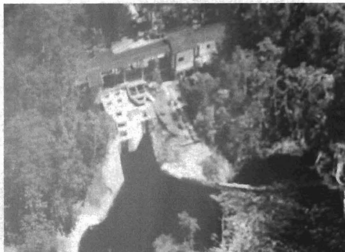
Figura 11 – Vista aérea da captação
