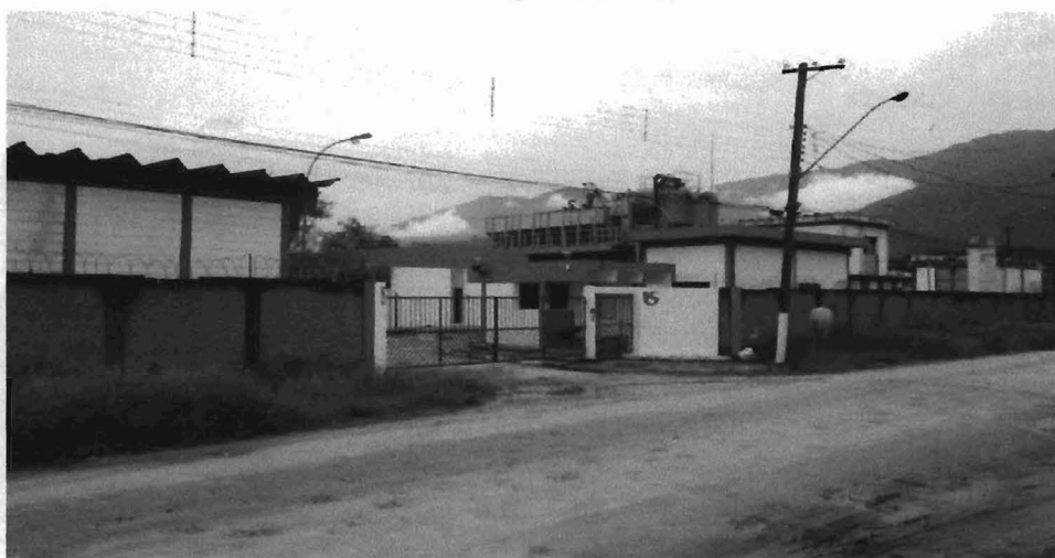
Figura 30 – Vista da ETE Bertioga I
