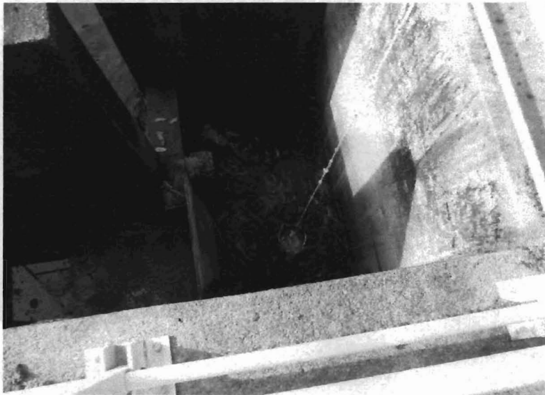
Figura 31 – Chegada do esgoto bruto na ETE Bertioga I
