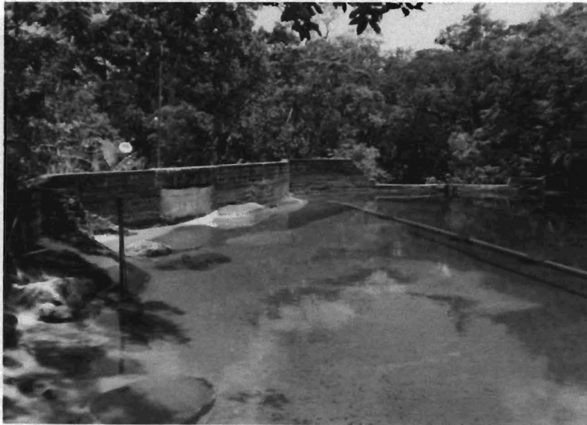
Figura 25 – Vista da Captação Loteamento Morada da Praia
