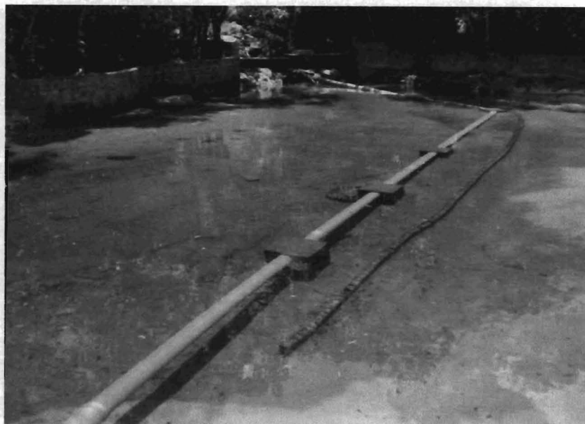
Figura 26 - Tanque de acumulação e vertedouro ao fundo
