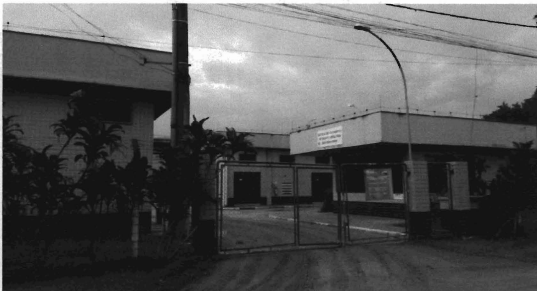
Figura 34 – Vista da ETE Vista Linda
