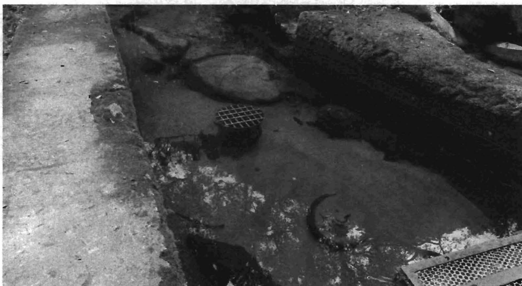
Figura 5 – Captação Furnas- SABESP
