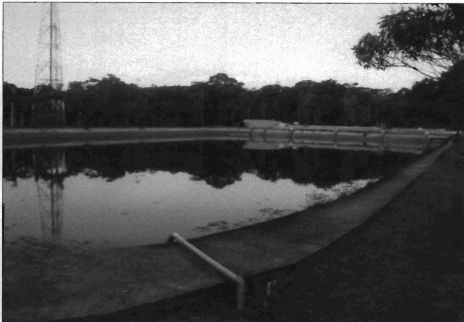
Figura 40 – Lagoa Anaeróbia
