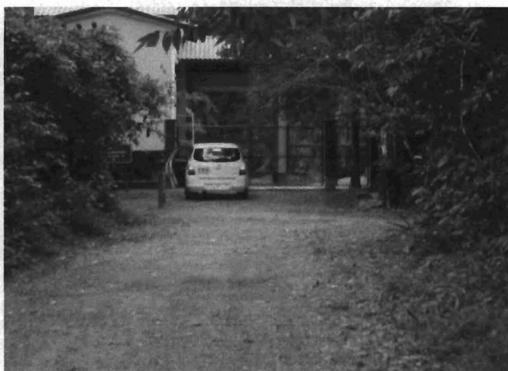
Figura 12 - Chegada na Estação de bombeamento, adução e recalque da água bruta – EBAR da Riviera de São Lourenço
